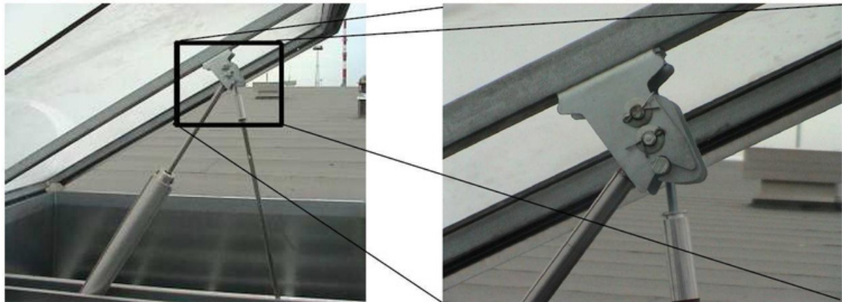
Bild 22. Anslutning av utlösare med hakkonsol
